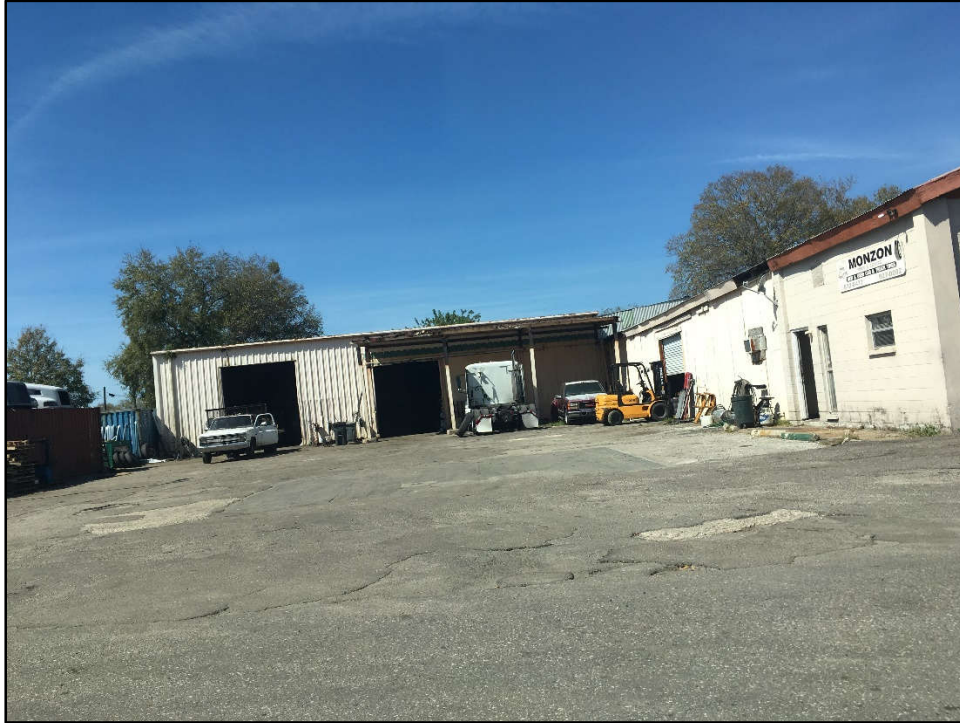
Photo 1: The Inco-Increte Site (N. Clark Avenue facing west).
